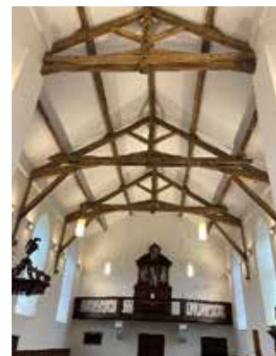
Eglise de Vaux-Chavanne
